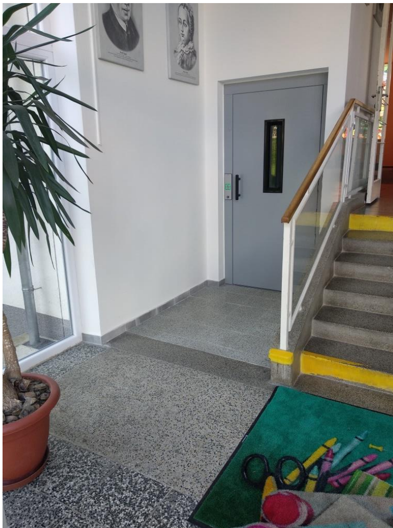
výtah u hlavního vchodu do budovy
